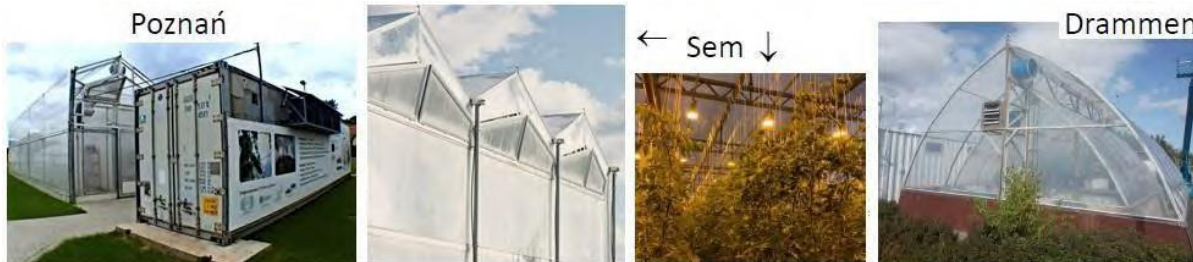
Rys. 10. Magazynowanie lub uwalnianie ciepła w cieplarniach BBBS – lampy doświetlające produkujące ciepło oraz wywiewniki i wentylatory do odprowadzania jego nadmiaru (Fot. L. Dawidowicz, M. Dominiczak, Reklima, Den Magiske Fabrikken, [9]).
