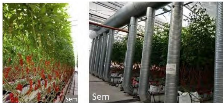
Rys. 11. Dostarczanie do cieplarni \text{CO}_2 z biogazowni w celu polepszenia wzrostu roślin (Fot. L. Dawidowicz).
