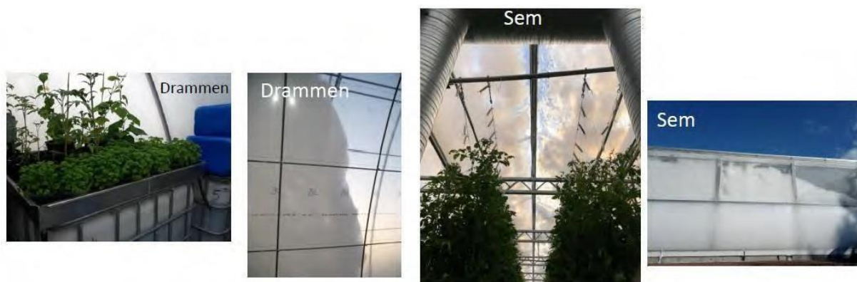
Rys. 6. Krążąca piana w układzie zamkniętym w zbiornikach utworzonych przez ściany i dachy cieplarni (Fot. L. Dawidowicz, Food to Waste to Food (F2W2F)).
