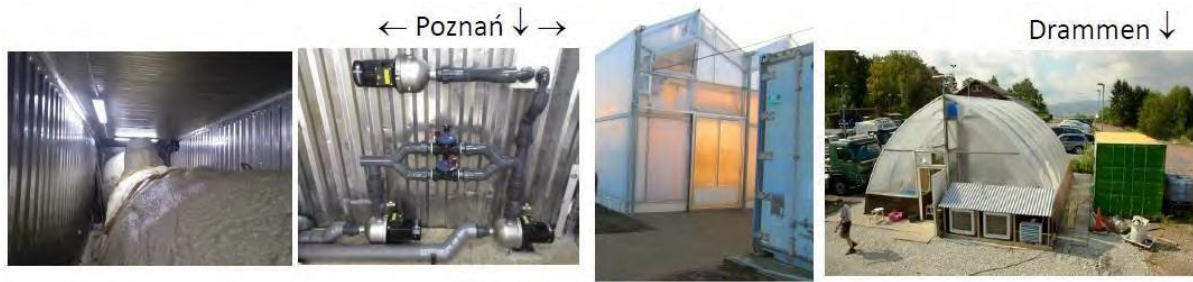
Rys. 9. Kontenery z wymiennikami ciepła zlokalizowane przy cieplarniach (Fot. L. Dawidowicz, Food to Waste to Food (F2W2F)).
