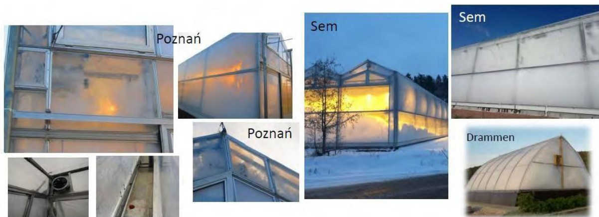
Rys. 5. Krążąca piana pomiędzy dwiema warstwami folii, wywarzana przez generatory ze środka pianotwórczego (Fot. L. Dawidowicz, Food to Waste to Food (F2W2F)).
