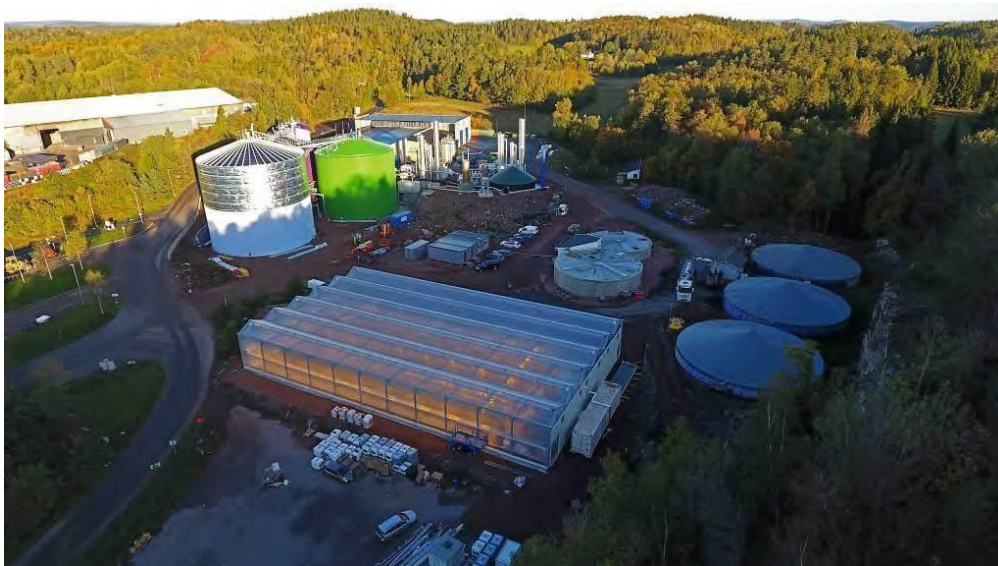
Rys. 1. Magiczna Fabryka – połączenie aktywnej ciepłarni BBBS z biogazownią rolniczą (Fot. Greve Biogass).
