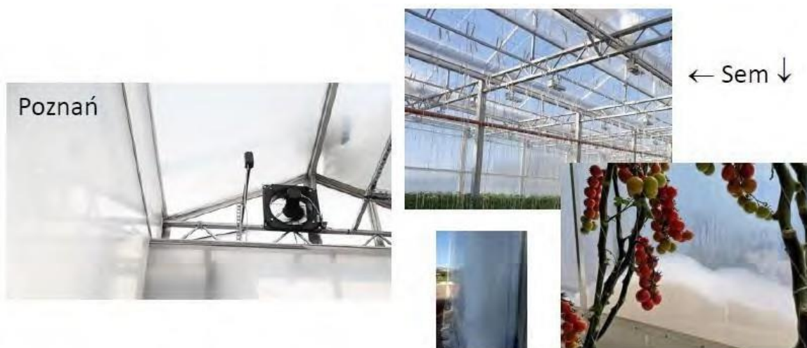
Rys. 8. Izolacja pianą poszczególnych części ścian lub dachu cieplarni BBBS w zależności od warunków pogodowych (Fot. Food to Waste to Food (F2W2F), [10,11]).
