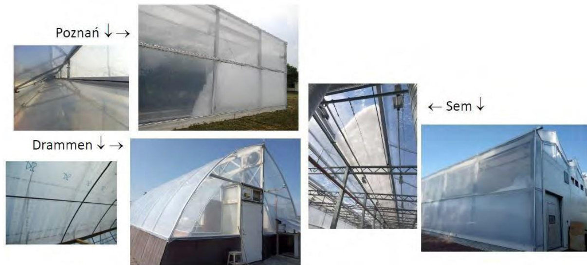
Rys. 4. Budowa ścian i dachów cieplarni BBBLs w Poznaniu, Drammen i Sem (Fot. L. Dawidowicz, Den Magiske Fabrikken, Food to Waste to Food (F2W2F)).
